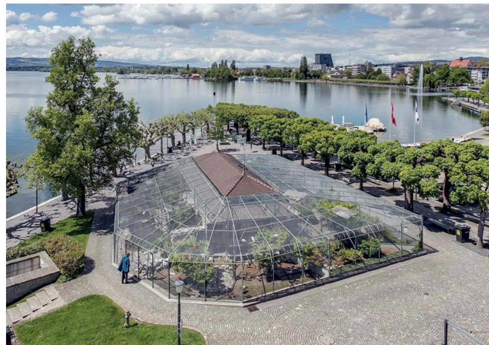
Die Fasanerie beim Landsgemeindeplatz. Foto: Benedikt Steinle
