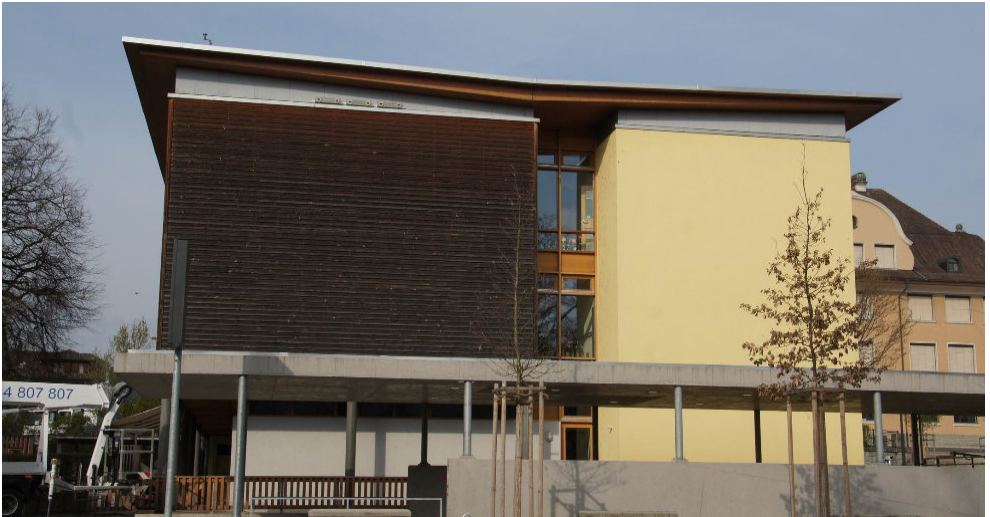
Mauersegler-Nistkästen beim Kirchbühl, Cham
